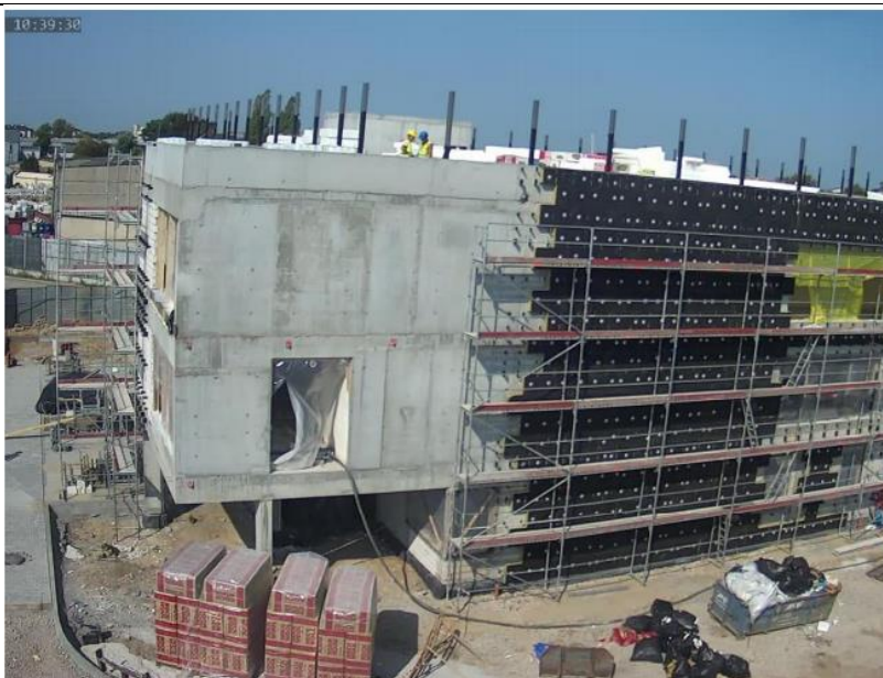
Obraz 1. Budowa nowego zakładu (listopad 2018 r.)
